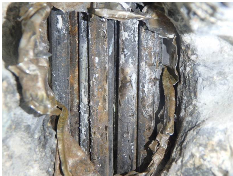
Sonda PV 7 – bez injektáže, dráty ojedinělá povrchová koroze
