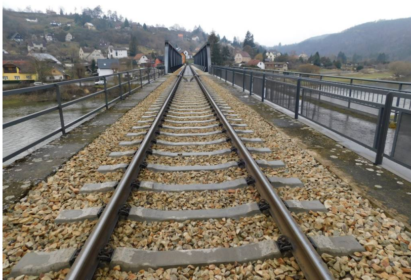
Drážní svršek po směru staničení
