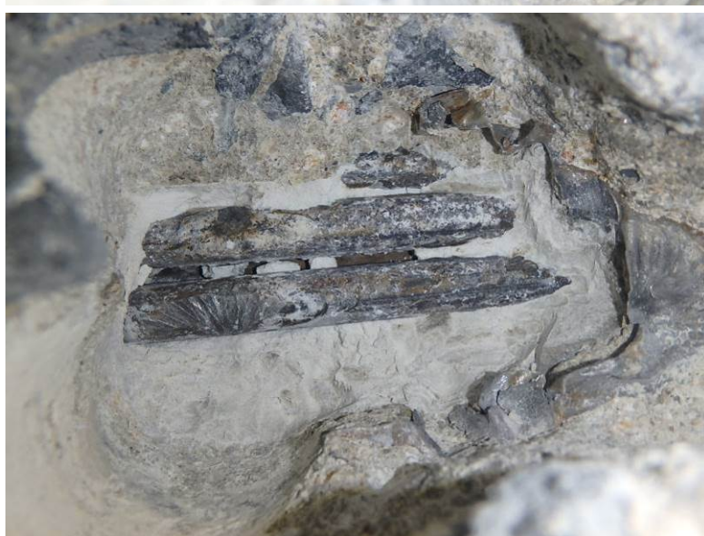
Sonda PV 12 – zainjektováno (mezi dráty vzduchová dutina), dráty bez koroze, malta suchá
