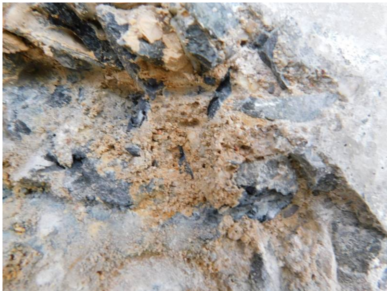
Detail struktury betonu s pískovými vměstkami.
