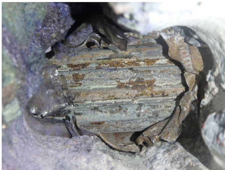
Sonda PV 5 – nedostatečně zainjektováno, dráty místy povrchová koroze
