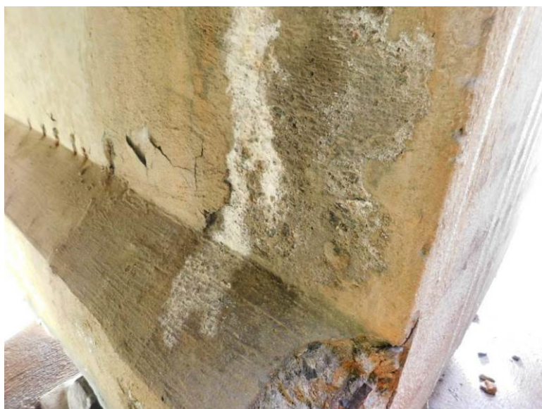
Detail lokálních průsaků na koncové dobetonávce nosníků nad P3
