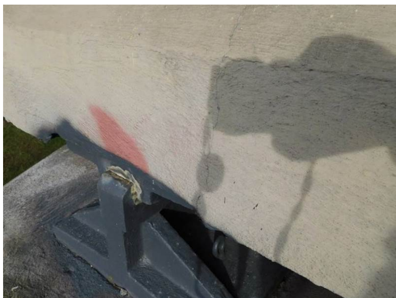
Vlasové trhliny v místě dobetonávky čel nosníků nad O1
