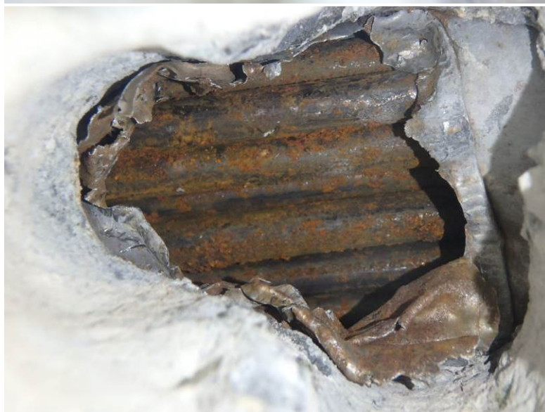
Sonda PV 11 – bez injektáže, dráty povrchově korodují
