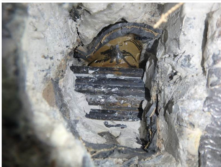
Sonda PV 9 – nedostatečně zainjektováno, dráty bez koroze
