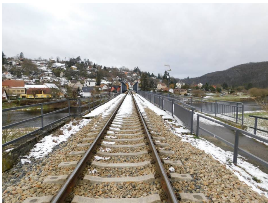
Pohled na uspořádání mostního svršku
