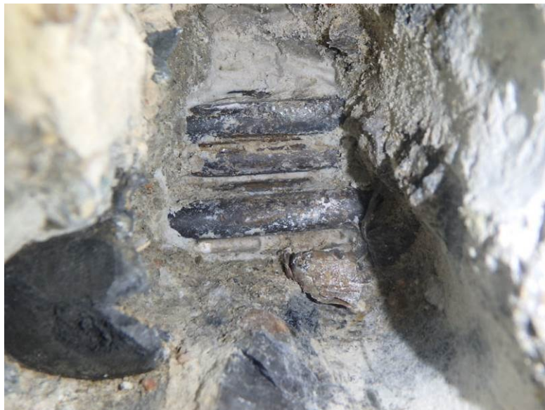
Sonda PV 1 – malty vlhká, na některých drátech ojedinělé slabé stopy povrchové koroze
