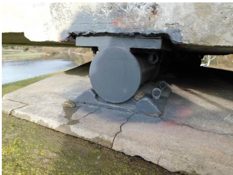
Detail stavu ložisek na P2
