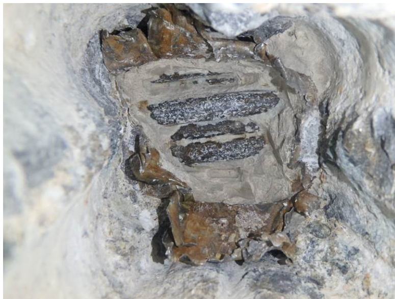
Sonda PV 4 – zainjektováno, dráty bez koroze, malta suchá
