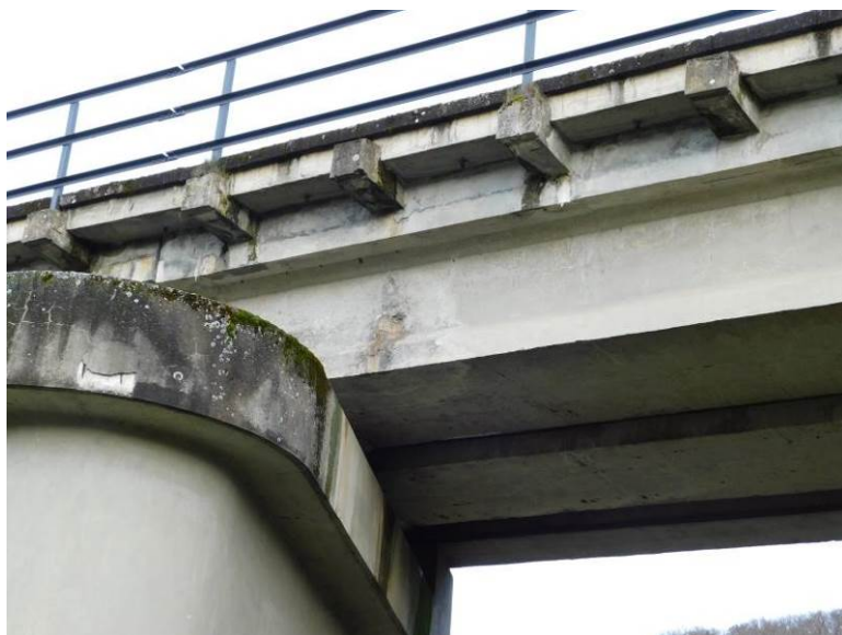
Poruchy s průsaky na boční ploše nosníků
