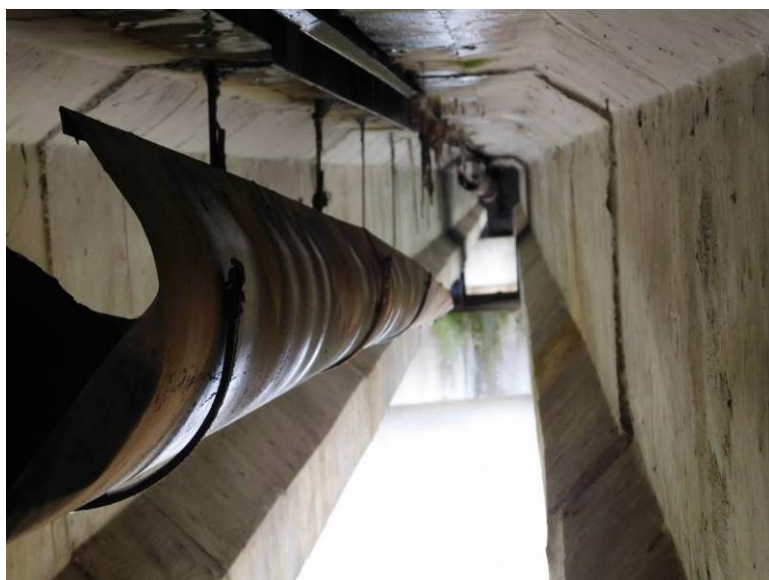
Poškozený žlab odvodnění v podélné ose mostu
