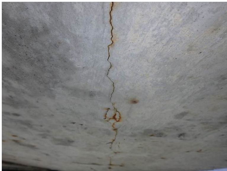
Trhliny na spodním líci konstrukce
