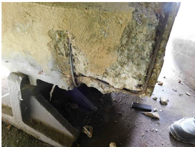
Lokální degradace betonu na koncové dobetonávce nosníků nad P3
