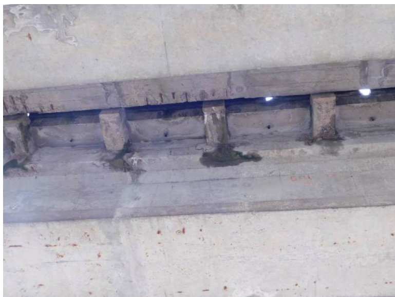
Poruchy s průsaky u konzol mostovky
