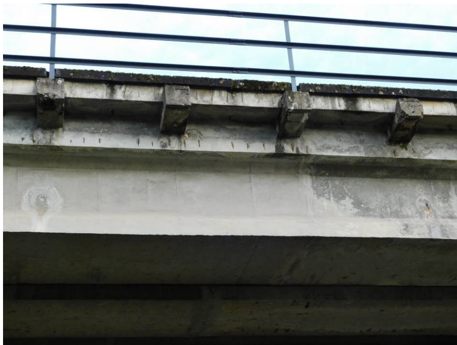
Detail prefabrikovaných příčných konzol s kabelovým žlabem
