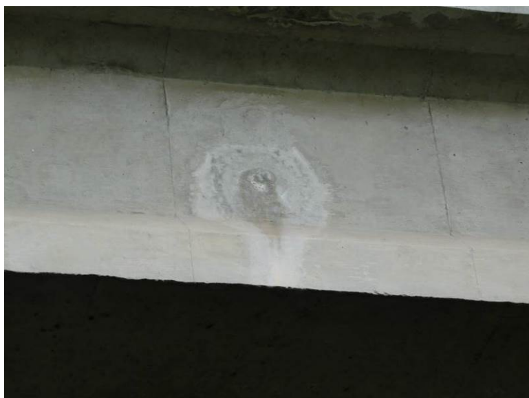
Poruchy s průsaky na boční ploše nosníků
