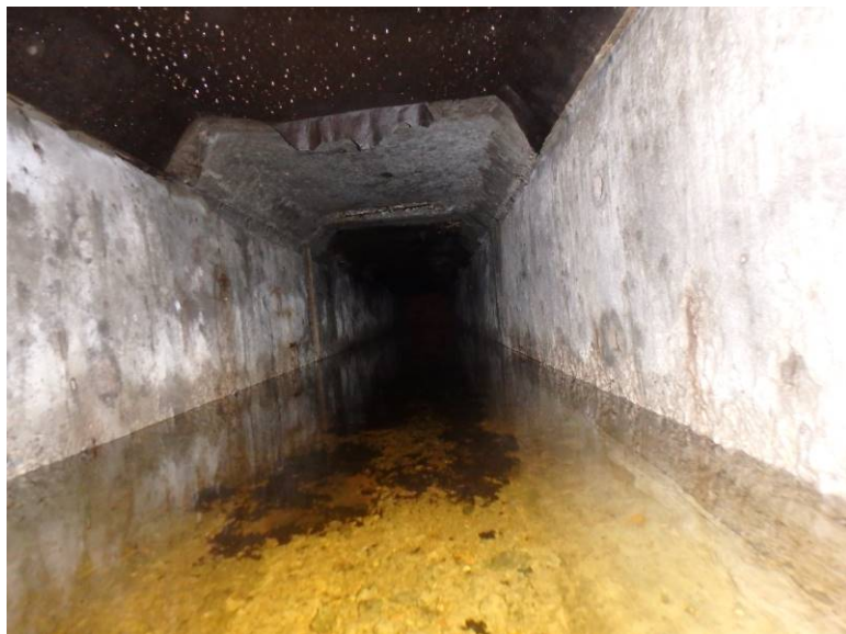
Pohled do dutiny D1 - nosník N2 v poli 2, kde bylo zjištěno větší množství zadržované vody
