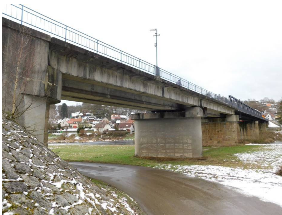
Pohled na pravou stranu mostu (ke konstrukci drážního mostu přiléhá samostatná konstrukce lávky pro pěší)
