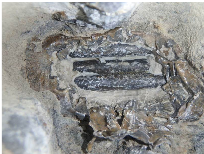
Sonda PV 6 – zainjektováno, dráty bez koroze, malta suchá
