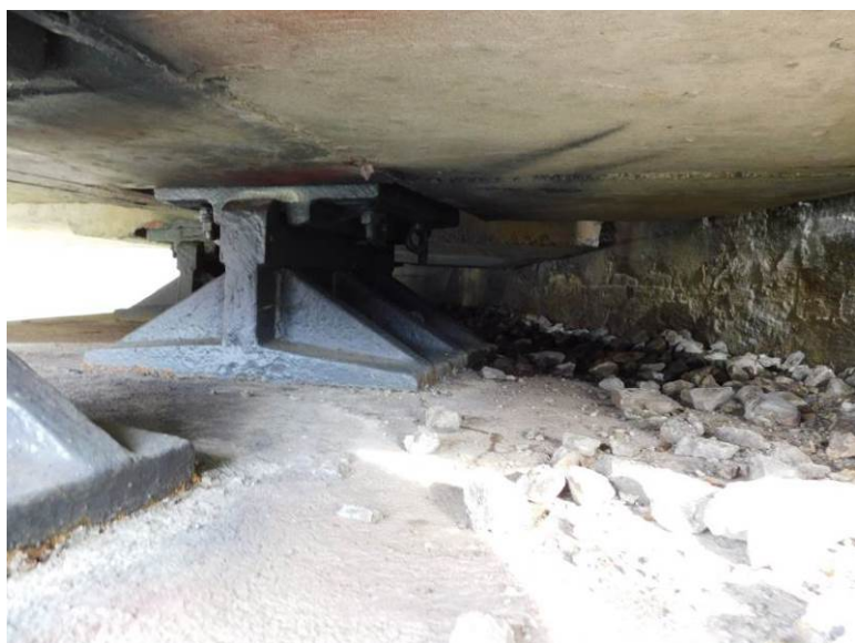
Detail stavu ložisek na O1
