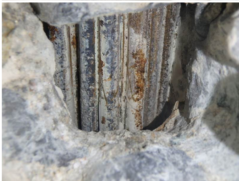
Sonda PV 3 - zainjektováno 10 mm na dně, zbytek kaverna, dráty místy povrchová koroze
