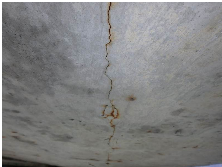
Detail podélné trhliny na spodním líci konstrukce
