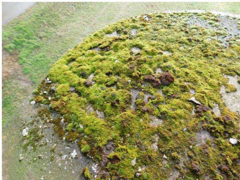
Povrch úložného prahu P3
