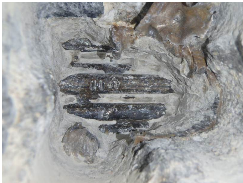
Sonda PV 8 – zainjektováno, dráty bez koroze, malta suchá
