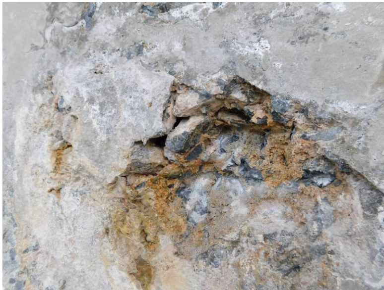
Detail struktury betonu s pískovými vměstkami.
