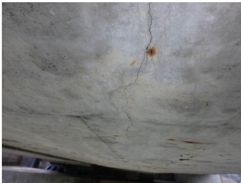
Podélná trhlina na spodním líci konstrukce
