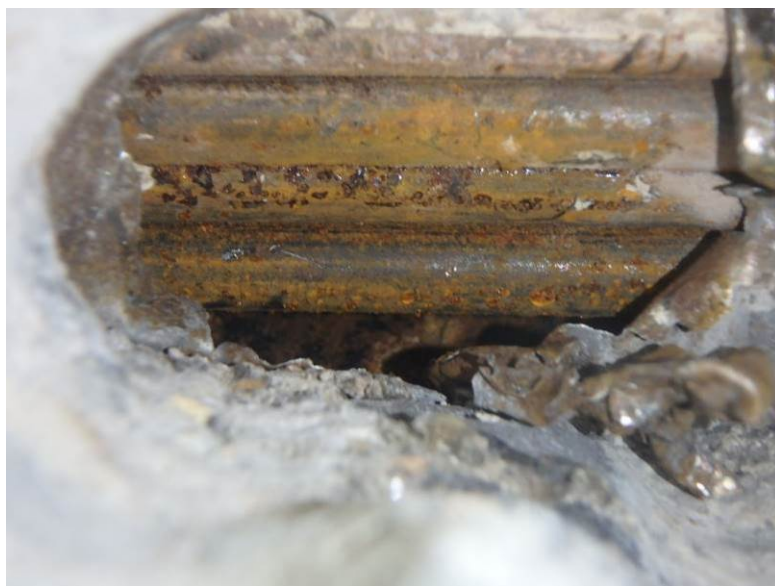
Sonda PV 10 – bez injektáže, dráty povrchově korodují
