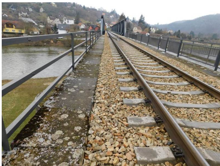
Detail mostního svršku – římsa a zábradlí
