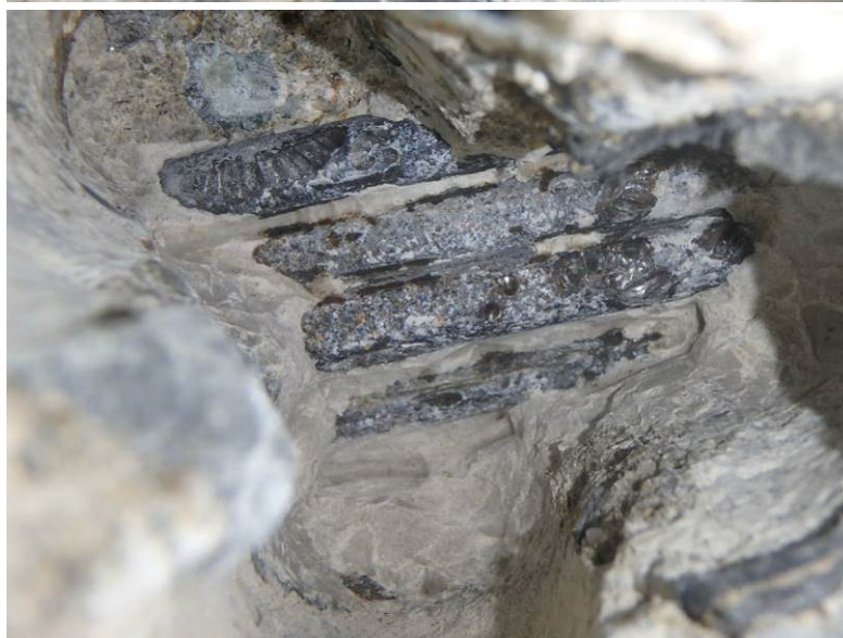
Sonda PV 2 – dráty bez koroze, malta suchá
