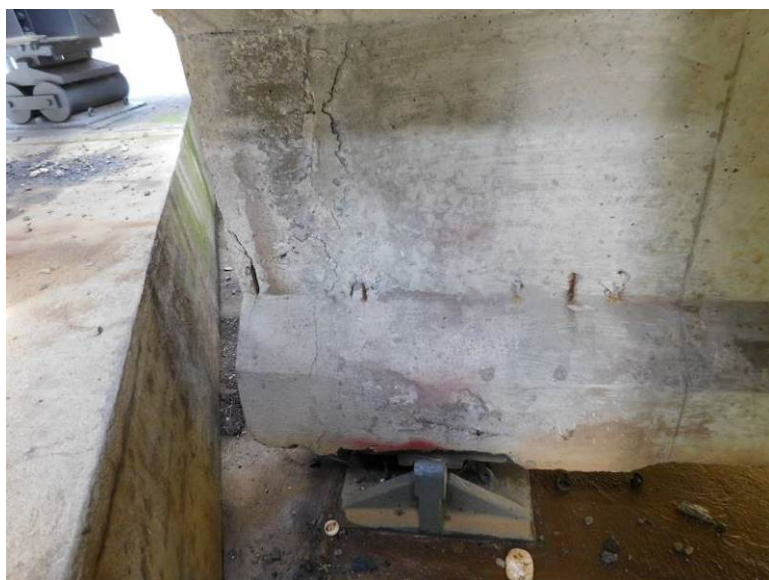
Detail stavu ložisek a porušená koncová dobetonávka na P3
