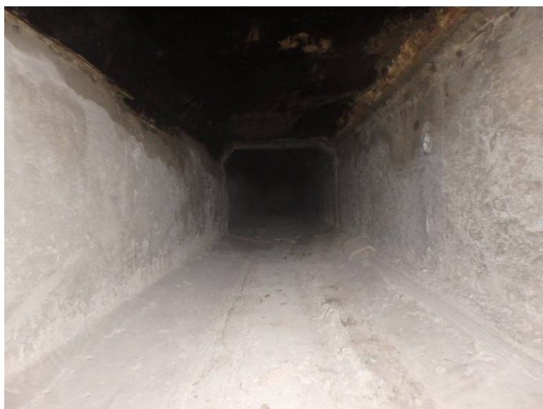
Pohled do dutiny D2 - nosník N1 v poli 2, v dutině je drobné množství vody u P3, zbytek dutiny je suchý. Lokální průsaky byly zjištěny v horní desce nosníku.
